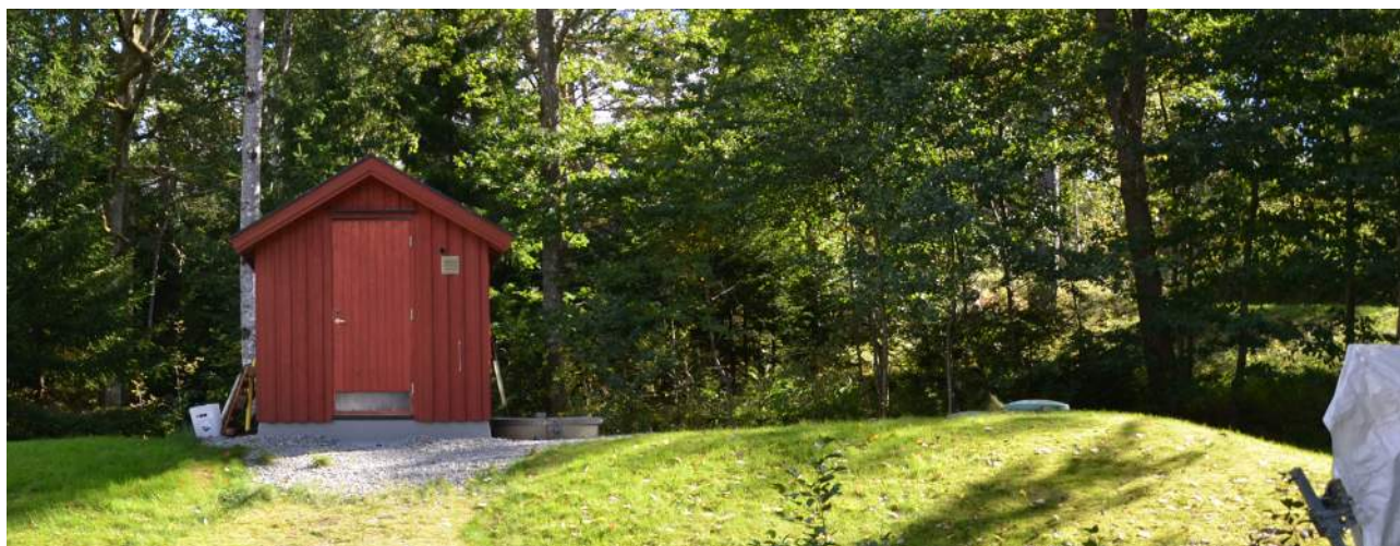
Reningsverket i Skåpesund med servicehus, i augusti 2012.
