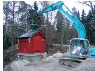
Installation av BAGA RVBK i Skåpesund, Januari 2006.
