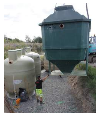
Installation av BAGA Compact
